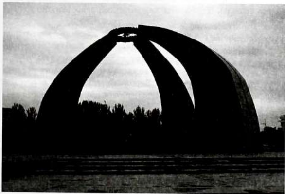
Т. С. Садыков. Архитектурный комплекс "Победы". Центральная часть.
